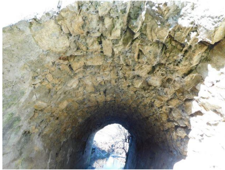
Slika 1. Pogled na rasponsku konstrukciju propusta
