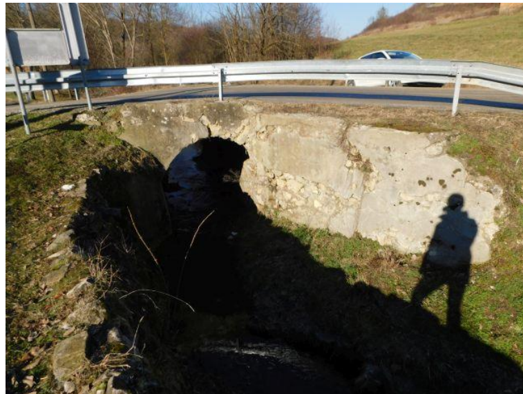
Slika 4. Pogled na propust i korito vodotoka
