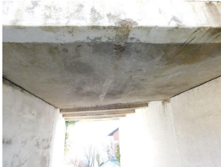
Slika 1. Pogled na rasponsku konstrukciju mosta
