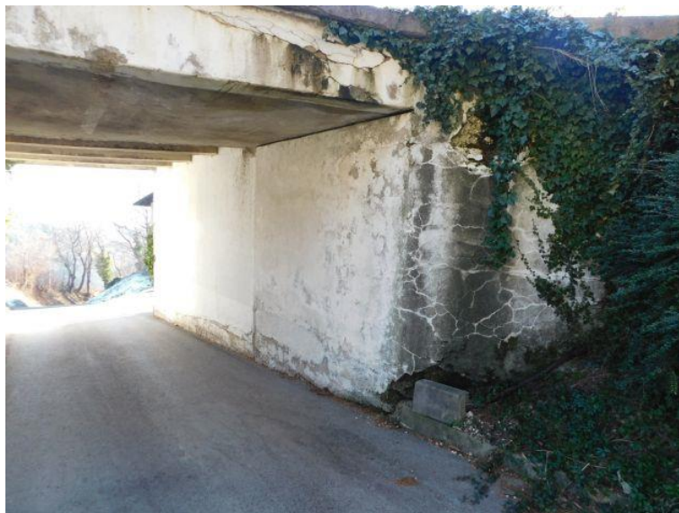
Slika 2. Pogled na upornjak
