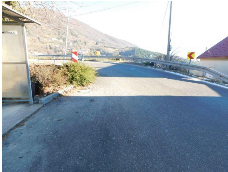
Slika 1. Pogled na prometnu površinu mosta
