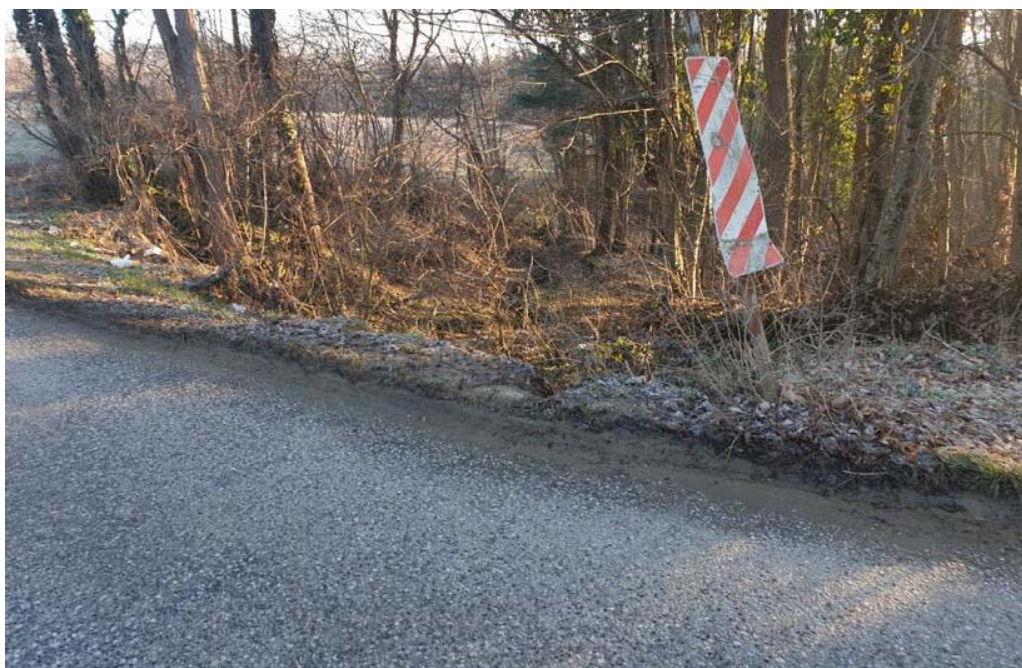
Slika: „ŽC 3002 – Radoišće; Stacionaža: km 5+240.
