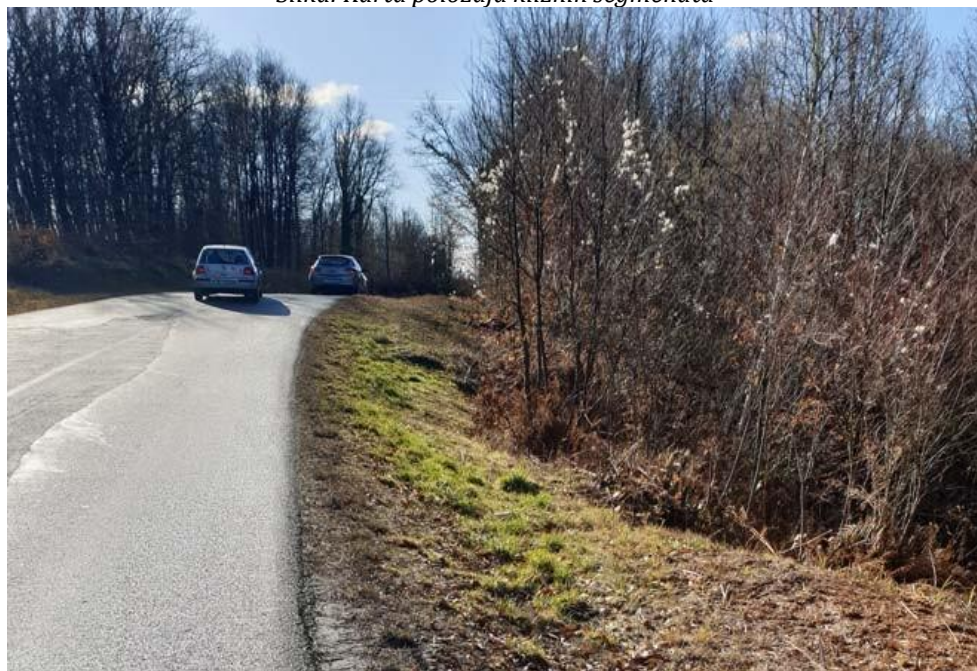
Slika: S padine iz gornji kota i ceste površinska voda se slijeva na čelo klizišta; Pukotine su vidljive na većim širim površinama
