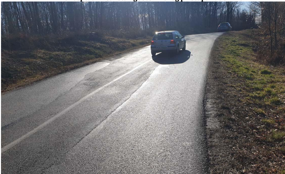
Županijska cesta ŽC 3155; Stacionaža: 4+050
